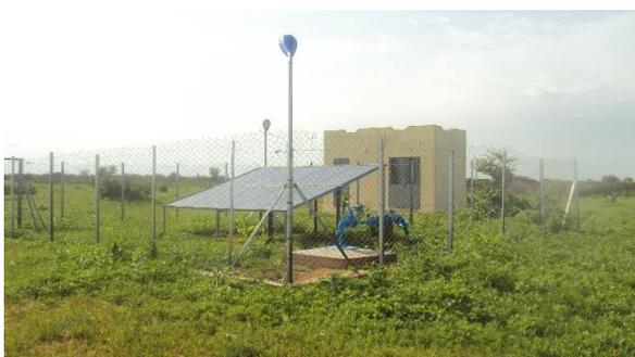
Un **générateur solaire** est composé d'un ensemble de **panneaux solaires (photovoltaïques)** reliés entre eux, et qui produisent un courant continu à partir de la lumière du soleil. Ensuite, un convertisseur-onduleur électronique transforme ce courant continu en courant alternatif, utilisable par une pompe de forage.
