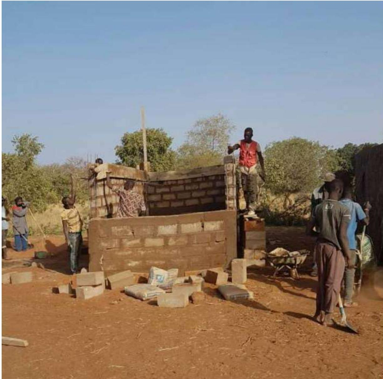
Construction d'un bassin-réservoir de 10 m<sup>3</sup>
