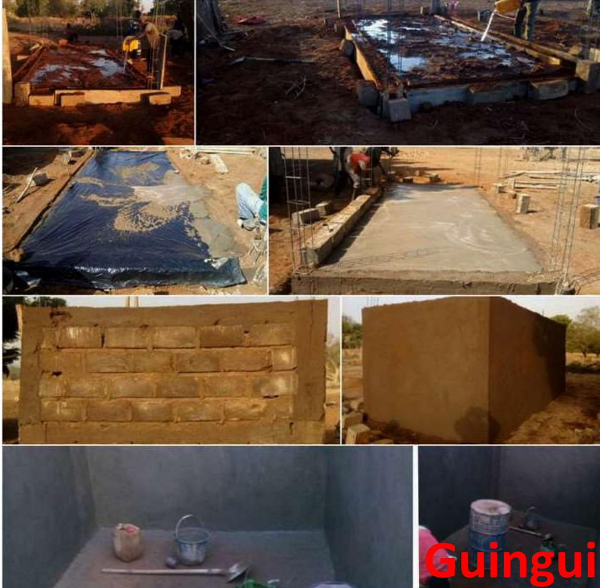
Construction d'un bassin-réservoir de 10 m<sup>3</sup>
