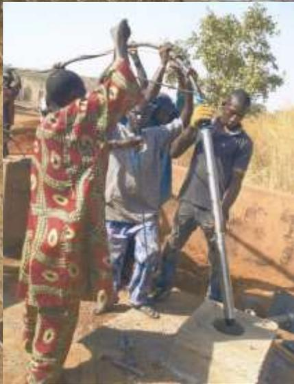
Descente d'une pompe électrique dans un forage profond
