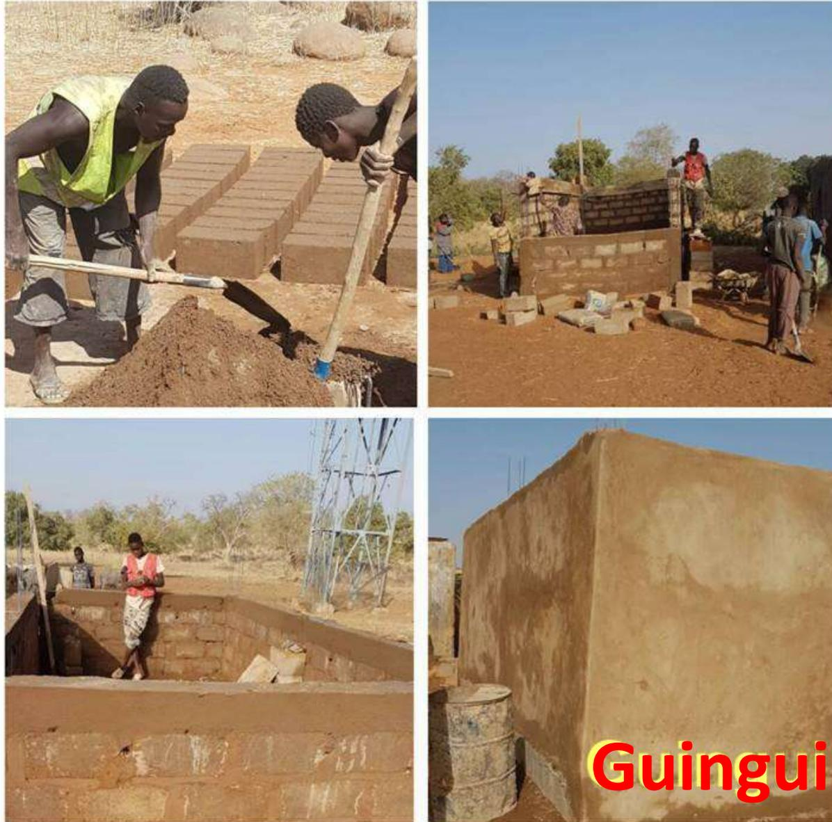
Construction d'un bassin-réservoir de 10 m<sup>3</sup>
