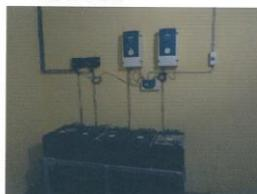
Photo N° 03: Vue d'ensemble Batteries, Convertisseurs et Régulateur
