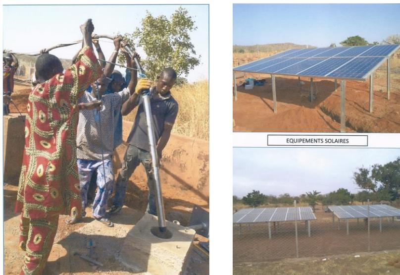
Descente d'une pompe électrique dans les forages de Guingui et de Foutougou
