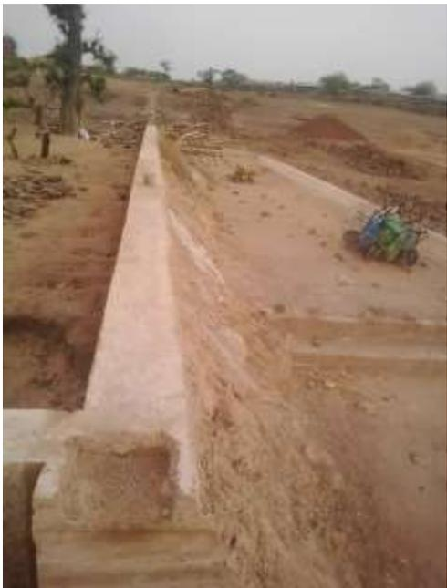
Noyau central en béton cyclopéen
