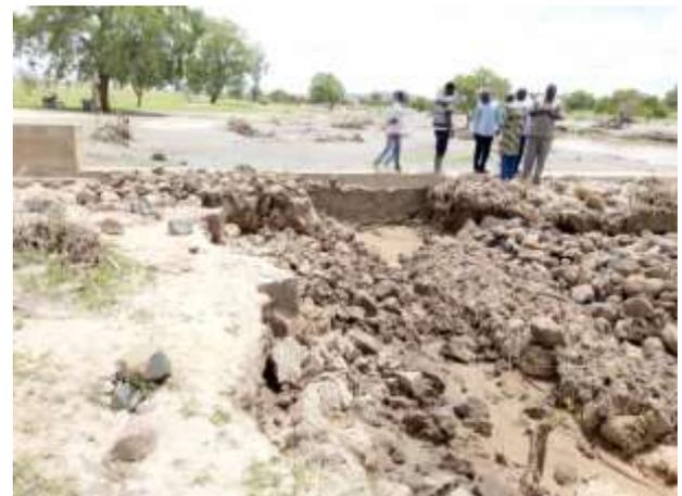
A Sécouréni, Les eaux de ruissellement ont érodé les berges, ce qui a entraîné l'effondrement du déversoir des deux côtés des murs bajoyer. Le bajoyer de la rive gauche, en cours de réalisation a été endommagé.
