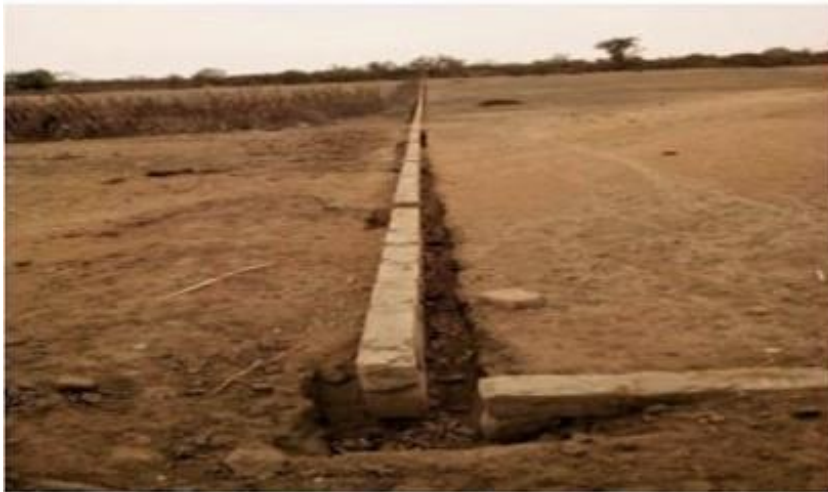
Soubassement de brique pleine de 15 prise de vue côté marécage
