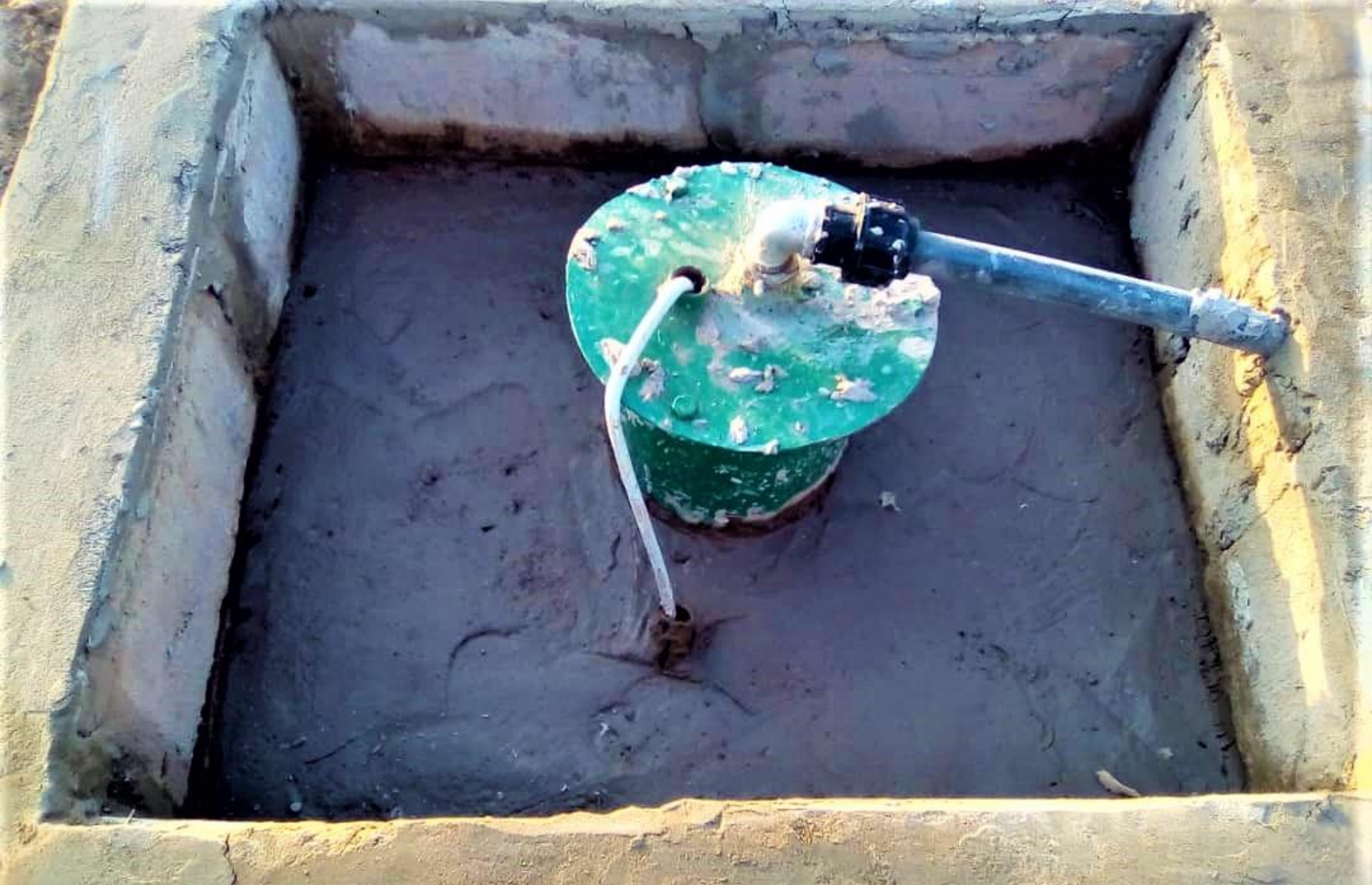
Equipement du forage avec une pompe électrique
