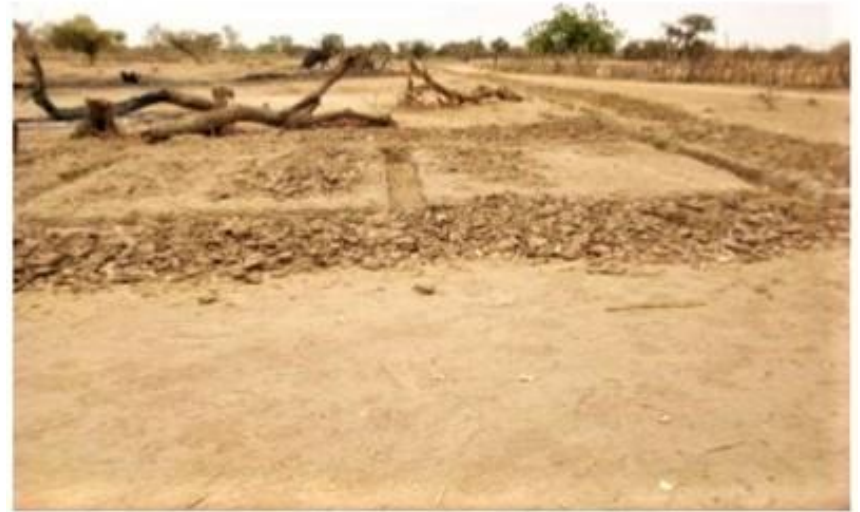
Vue des fondations des magasins
