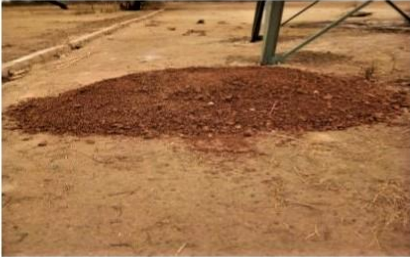
Vue sur l'approvisionnement en matériaux locaux (gravier)
