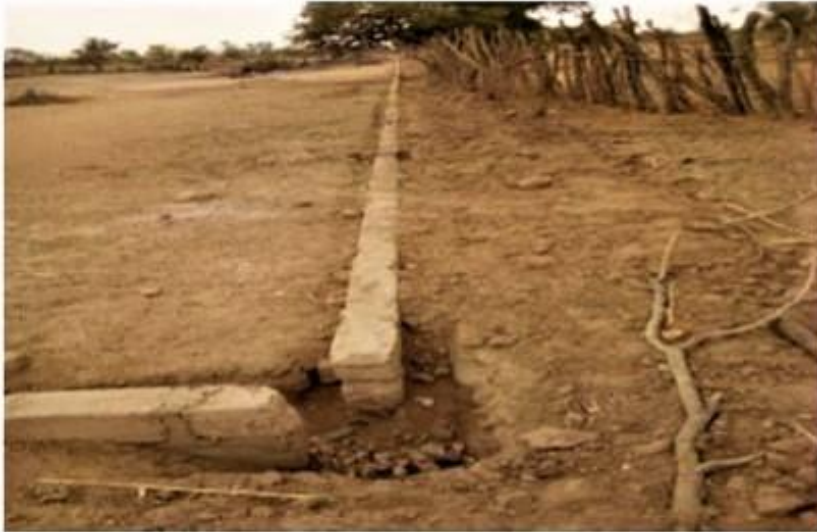
Soubassement de brique pleine de 15 prise de vue côté village
