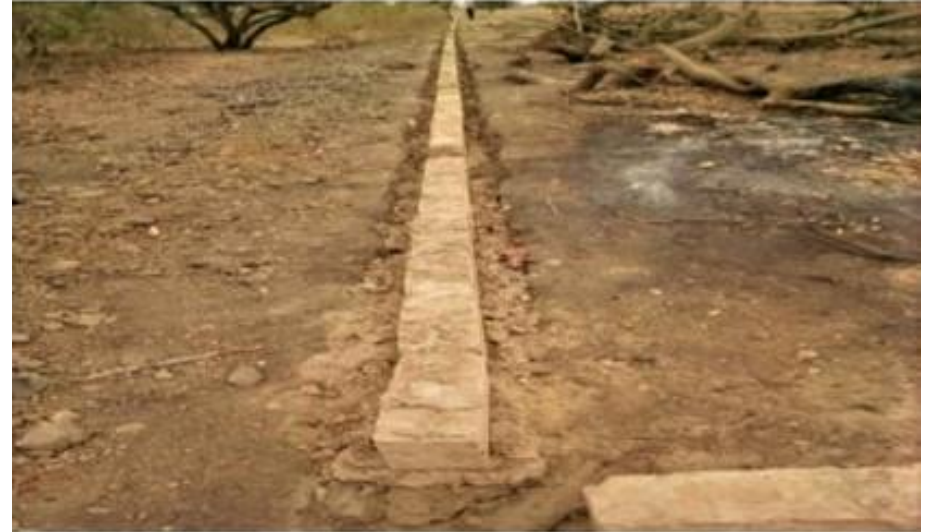
Soubassement de brique pleine de 15 prise de vue côté droit
