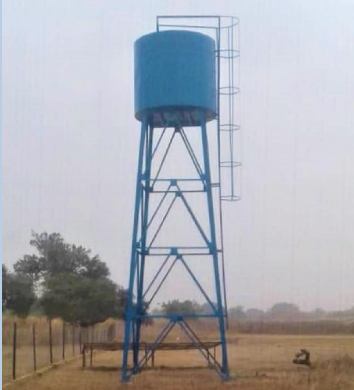
Le château d'eau après sa mise en peinture
