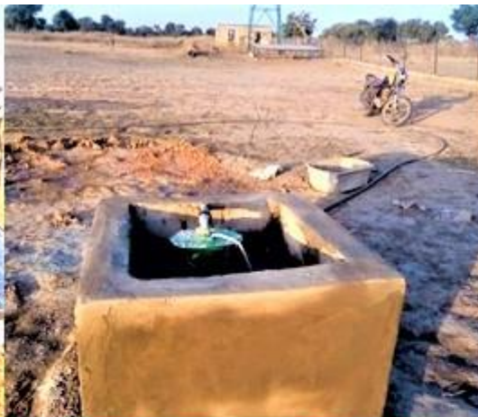
Équipement du forage avec une pompe électrique
