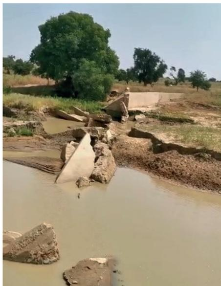
étaient quasiment achevées à la mi-juillet, de nouvelles pluies exceptionnelles ont submergé les ouvrages et altéré fortement les bases des digues. Tout particulièrement à Sécouréba, où l'ossature du barrage a été touchée en de multiples endroits et une partie emportée par la vague d'eau, ruinant les espoirs des villageois de bénéficier enfin des effets attendus des retenues d'eau.
