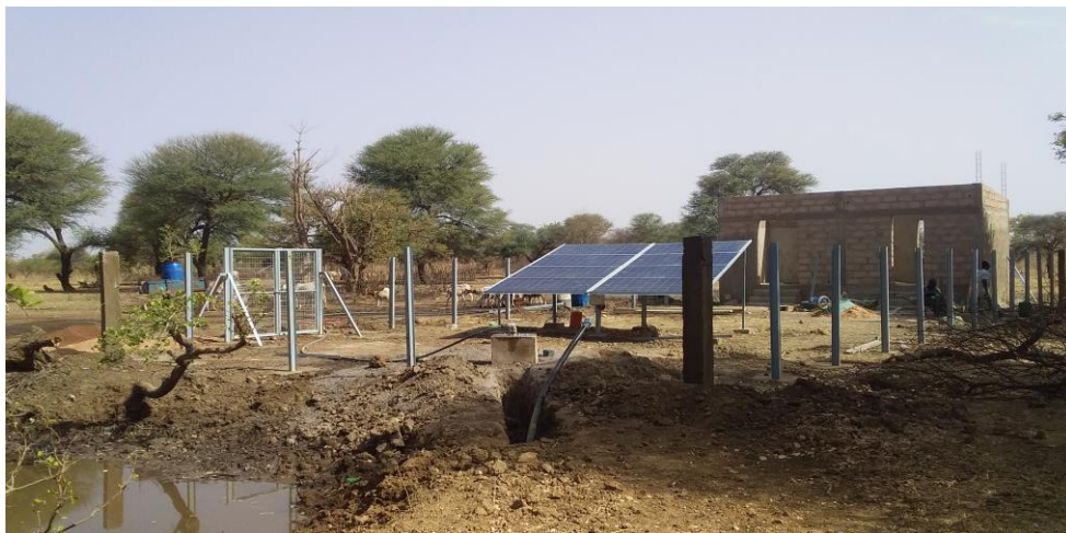
Le site clôture
